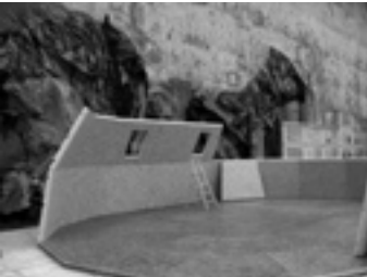
Montage du module au barrage de la Grande-Dixence
